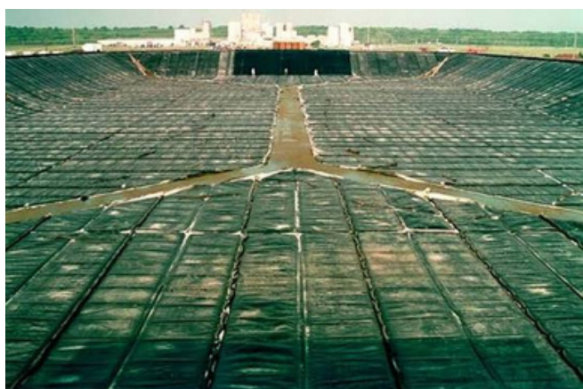
Hệ thống thu gom khí LemTec được thiết kế riêng để phù hợp với hồ xử lý nước thải, cho phép thu gom khí sinh học và sử dụng nhiên liệu tại nhiều quốc gia.
